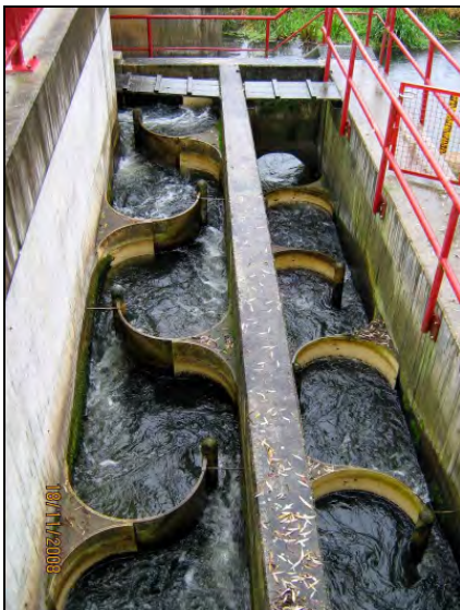
Abb. 25: Mäanderfischpass Schildfeld/ Schilde mit 2x abgeknickter Trassierung
