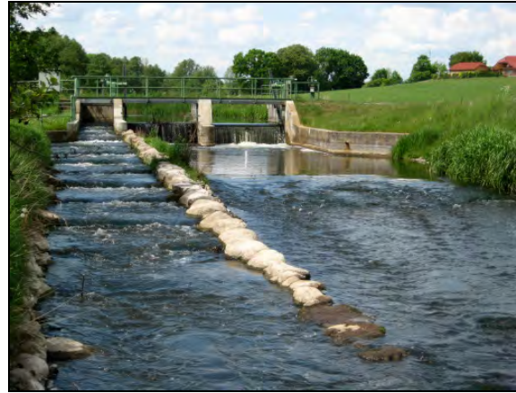
Abb. 11: Nutzung einer Wehrfeldbreite als Fischaufstieg bei gleichzeitigem Ersatzneubau des Wehres Gustävel/ Warnow
