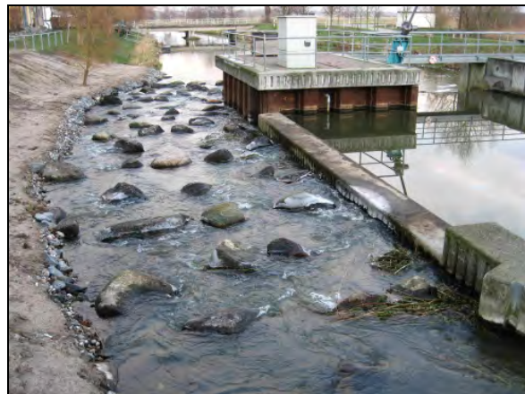
Abb. 16: Zustand nach dem Umbau; das Gefälle wurde reduziert bzw. besser verteilt und der Anteil der Störsteine zugunsten des Lückensystems reduziert
