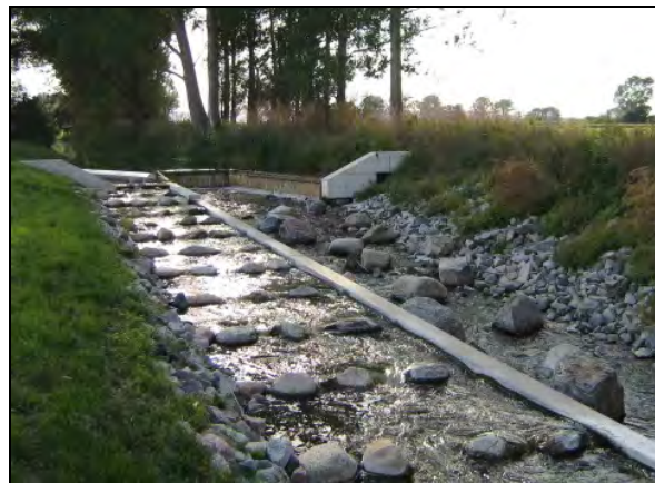
Abb. 30: Kombiniertes Bauwerk aus Raugerinne-Beckenpass (links) als FAA und Rampe zur HW-Entlastung; ehemaliges Messwehr Heinrichswalde/ Weißer Graben (Ablauf Galenbecker See)
