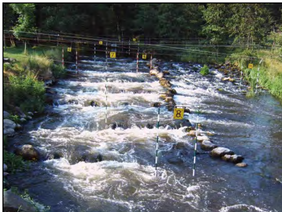
Abb. 29: Kombiniertes Bauwerk aus Raugerinne-Beckenpass (links) als FAA und Rauer Rampe zur HW-Entlastung, Eickhof/Warnow; zeitweise wird der Beckenpass von Kanuten als Wildwasser-Slalomstrecke genutzt
