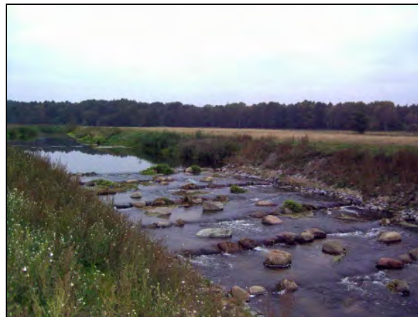
Abb. 9: Umbau zum festen Wehr als Raugerinne-Beckenpass; die Brücke konnte zurückgebaut werden, da die Wegequerung nicht erhalten bleiben brauchte
