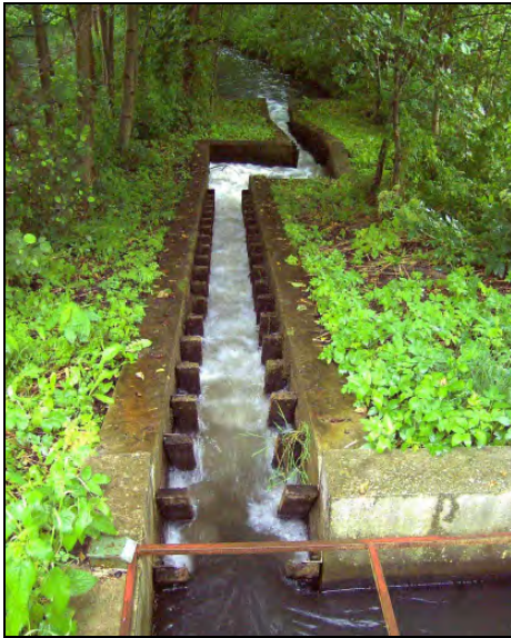
Abb. 14: Denilpass an der Gollmitzer Mühle/ Strom (Nordbrandenburg, Baujahr 1992), mit der Anlage wird ein Höhenunterschied von 3,65 m mit einem Gefälle von 1:4,75 (!) überwunden
