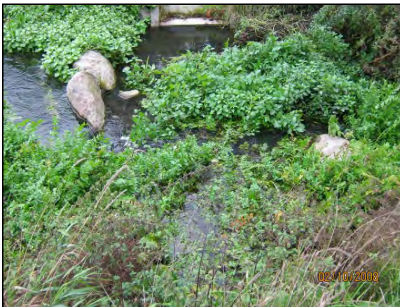
Abb. 55: Eingeschränkte Passierbarkeit einer FAA durch starke Verkräutung
