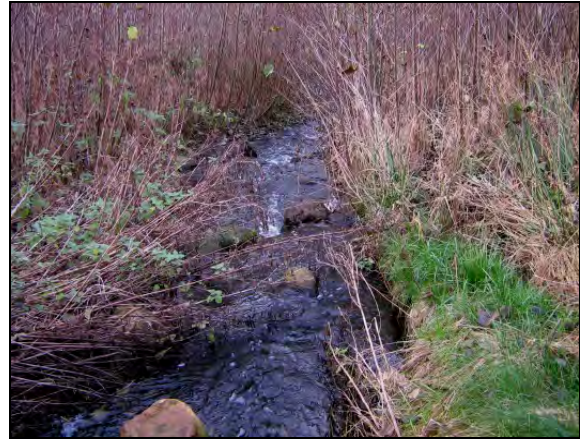
Abb. 54: Starker Jungerlen-Aufwuchs im Böschungsbereich und sukzessive fehlende Zugänglichkeit der Sohlengleite für Kontrolle und Wartung
