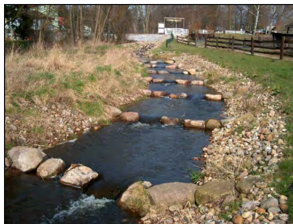
Abb. 20: Späterer Zustand, gut sichtbare seitliche Einbindung der Steinriegel im Böschungsbereich, Beschränkung auf eine Lücke pro Riegel aufgrund der relativ geringen Abflüsse im Sommerhalbjahr
