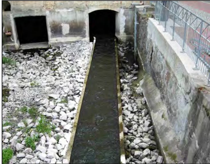
Abb. 28: Borsten-Fischpass im Brüeler Bach in Brüel bei Abflüssen kleiner MQ; die Anlage hat nach derzeitigem Kenntnisstand noch Optimierungsbedarf
