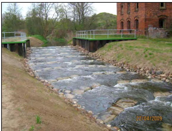
Abb. 17: Raugerinne-Beckenpass Kluss/Wallensteingraben; durch Verwendung relativ gleichförmiger Steine, die bei leicht erhöhten Abflüssen gleichmäßig überströmt werden, wird die Störanfälligkeit (Festsetzen von Treibsel) reduziert
