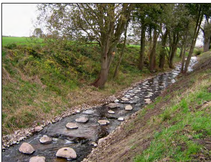
Abb. 7: Zustand nach Umbau zum Raugerinne-Beckenpass mit zusätzlichen Störsteinen in den Becken; die alten und scharfkantigen Wasserbausteine wurden ausgetauscht bzw. überdeckt
