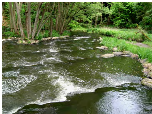
Abb. 18: Naturnaher Raugerinne-Beckenpass im Warnow-Durchbruchtal bei Karnin
