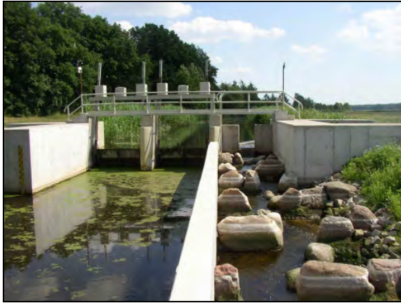
Abb. 10: Umbau eines Wehrfeldes als Fischaufstieg, Wehr südlich des Löcknitzer Sees/ Randow
