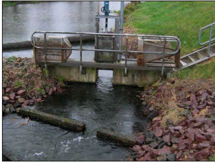
Abb. 52: Wehr als Einlaufbauwerk mit seitlich abgelegten Aalreusen; an Standorten mit Abflussaufteilung wird i.d.R. ein Einlaufbauwerk zur Durchflussbegrenzung in der FAA erforderlich; am Einlaufbauwerk sollten bereits bauseitig Befestigungsmöglichkeiten für Reusen zur Effizienzkontrolle vorgesehen werden
