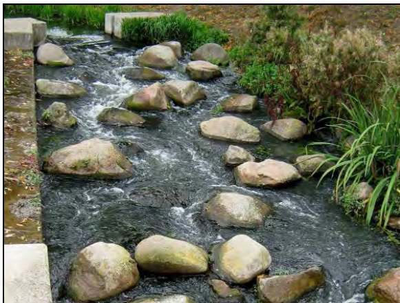
Abb. 15: Sohlengleite mit Störsteinen, Wehr Bad Sülze/ Recknitz, Zustand vor dem Umbau, durch großes Längsgefälle und engen Steinabstand im oberen Bereich hohe Turbulenzen
