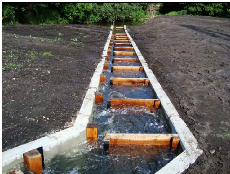
Abb. 23: Technischer Schlitzpass aus Eichenbohlenwänden in einem Stahlbeton-Trog (Standort: Öhlmühlenbach/ Neubrandenburg), Zustand kurz nach Fertigstellung
