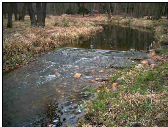
Abb. 32: Kleine Sohlenrampe zur Wasserstandsanhhebung im Godendorfer Mühlenbach; temporär durchgängig
