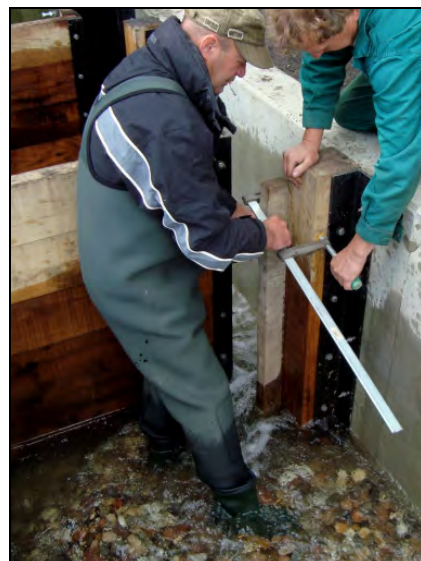
Abb. 24: Probelauf mit Anpassung der Schlitzbreiten, gut sichtbares Sohlsubstrat aus Grobkies
