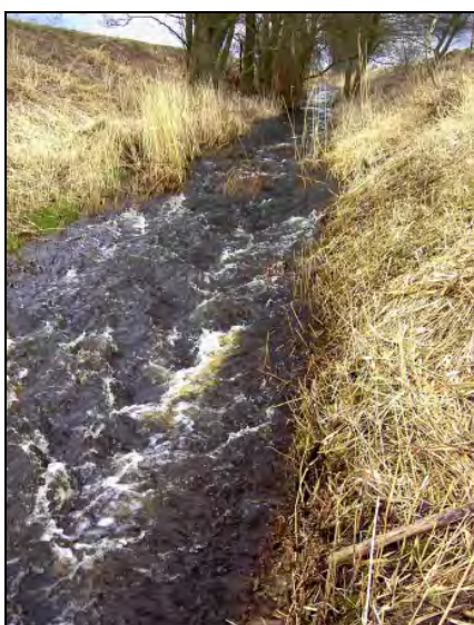
Abb. 6: Sohlgleite Prisannewitz/ Zarnow; mit Wasserbausteinen befestigte Gefällestrücke
