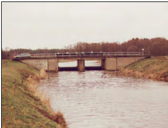
Abb. 8: Wehr Barenkuhl/ Zarow (regulierbar) mit Brücke; Ausgangszustand
