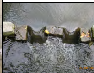
Detail Einlaufbauwerk (gegliederter Querschnitt)
