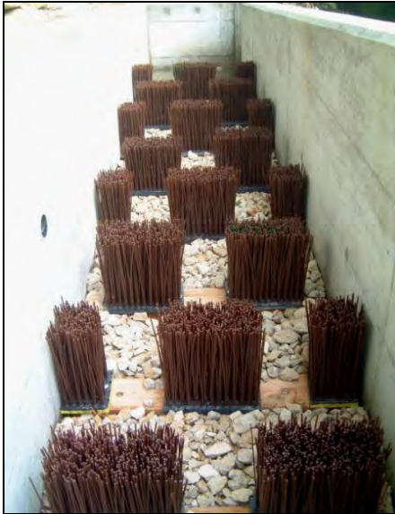
Abb. 27: Borsten-Fischpass im trockenen Zustand
