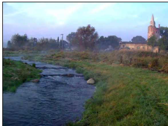
Abb. 13: Umgehungsgerinne mit Steinriegeln, Wehr Klempenow/ Tollense
