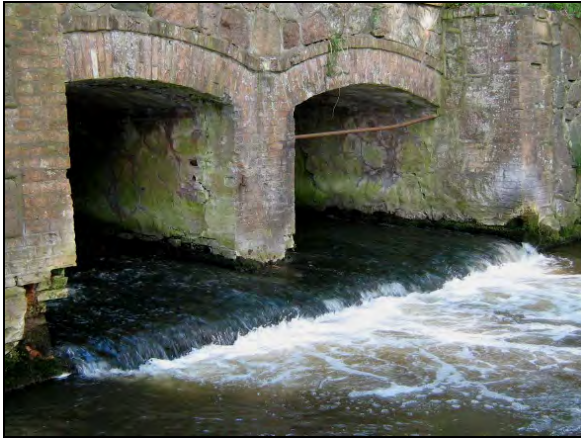
Abb. 3: Alter Doppeldurchlass im Aufraben bei Zachariae mit nicht passierbarem Absturz im Unterwasser
