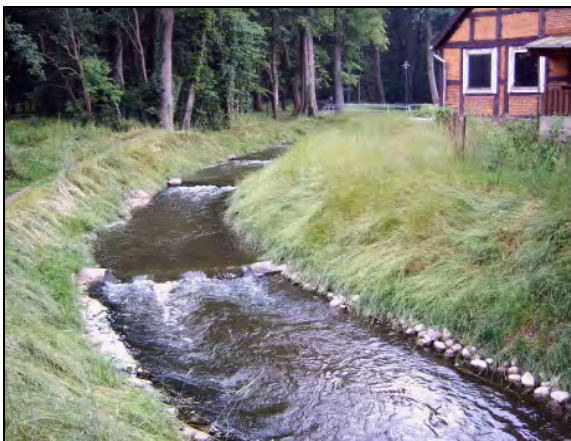
Abb. 12: Umgehungsgerinne mit Steinriegeln, Wehr Dobbertiner See/ Mildenitz
