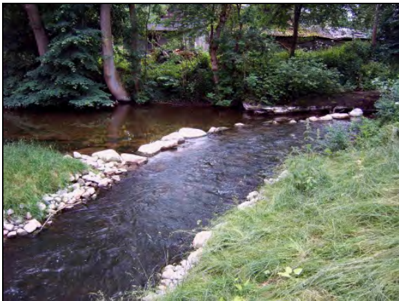
Abb. 49: Auslaufgestaltung bei einer FAA im Umgehungsgerinne; Steinriegel zum Hauptgerinne (Wehr) zur Lenkung der Lockströmung und Auffächerung der Strömung im Hauptgerinne
