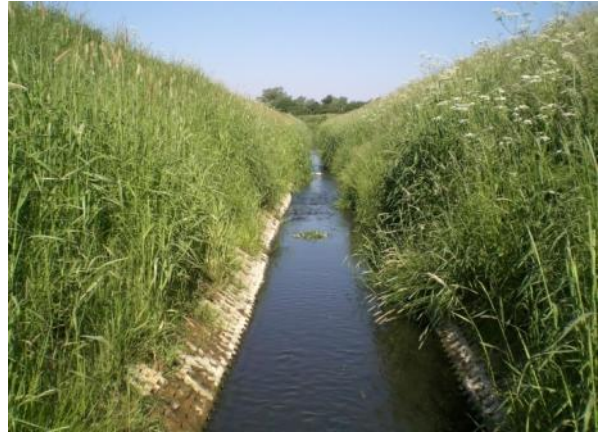
Rasengitter, Pflaster, Steinsatz unverlegt
