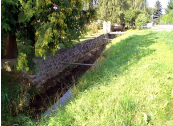
Beton, Mauerwerk, Pflaster verlegt
