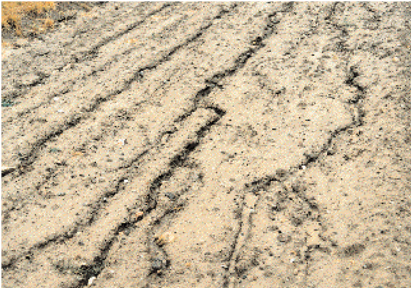
Abb. 5.12: Leiare Abtragungsformen a: Rille (Tiefe 2-<10 cm)
