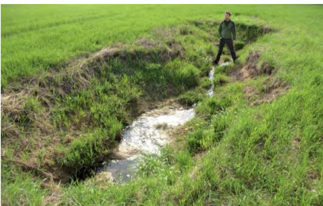
Abbildung 4-18: Durch Druckabfluss zerstörte Rohrleitung in einem Graben bei Elmenhorst (nahe Rostock), Foto: Institut biota GmbH
