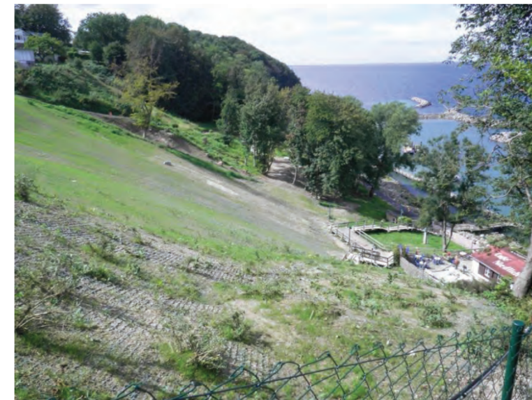
Der Küstenhang in Lohme nach der Sanierung und dem Einbau von Sicherungsmaßnahmen (Foto: K. Schütze, 2011).
